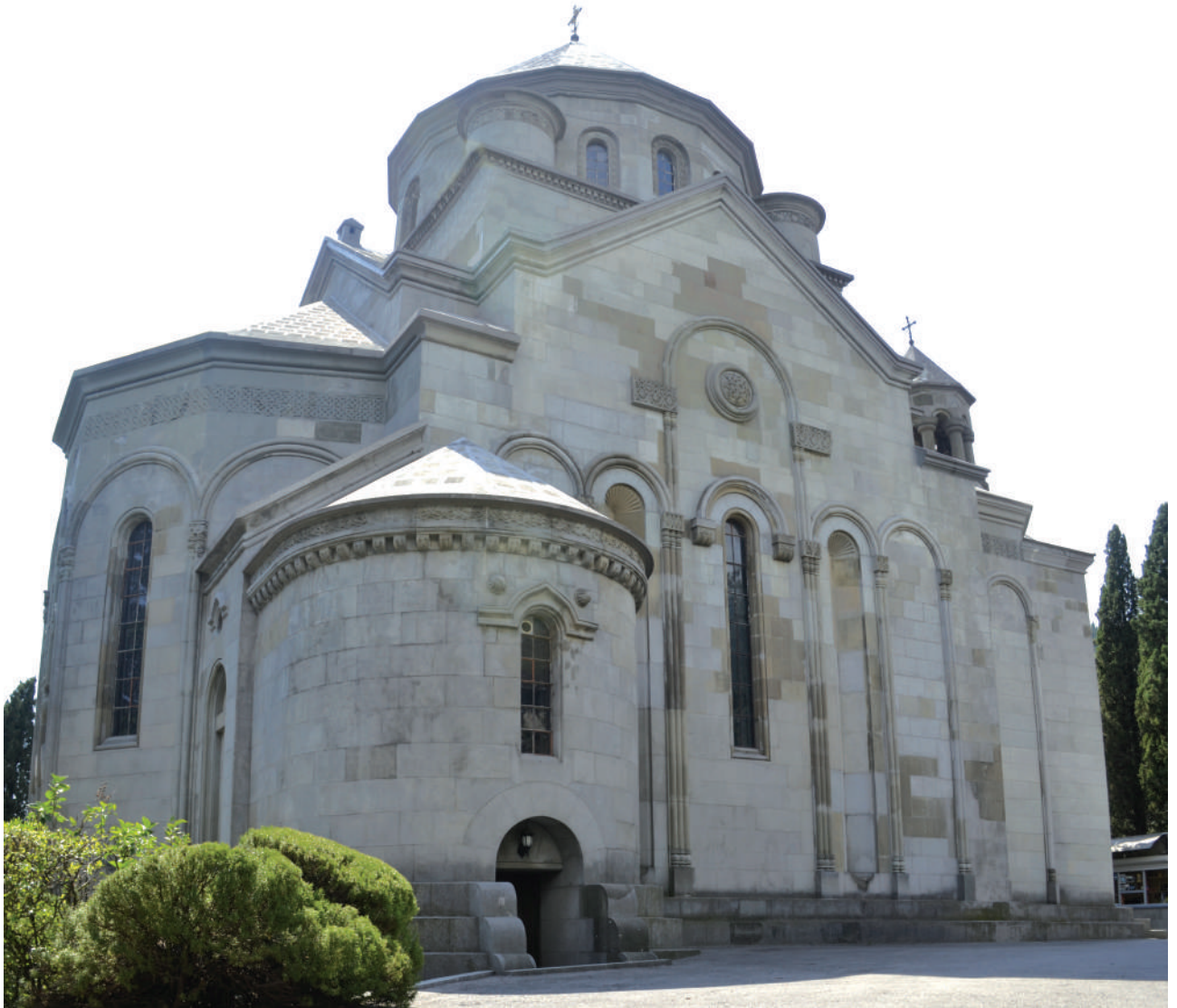
Илл. 12. Вид храма с северо-востока
