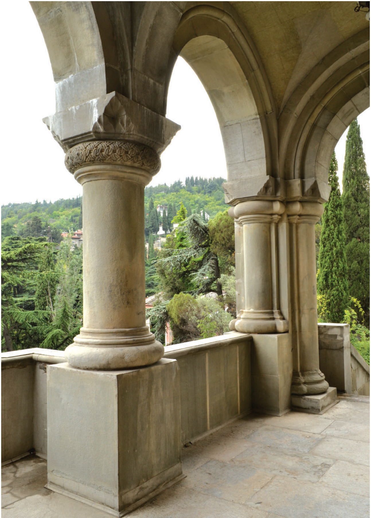
Илл. 111. Колонны лоджии
