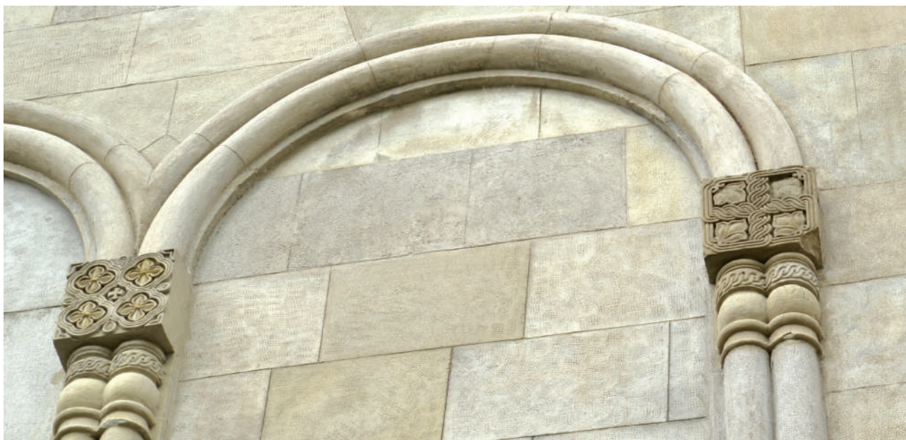
Илл. 88. Оформление капителей и импостов на северном фасаде
