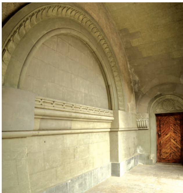
Илл. 48. Ложный портал в центре северной стены арки-галереи
