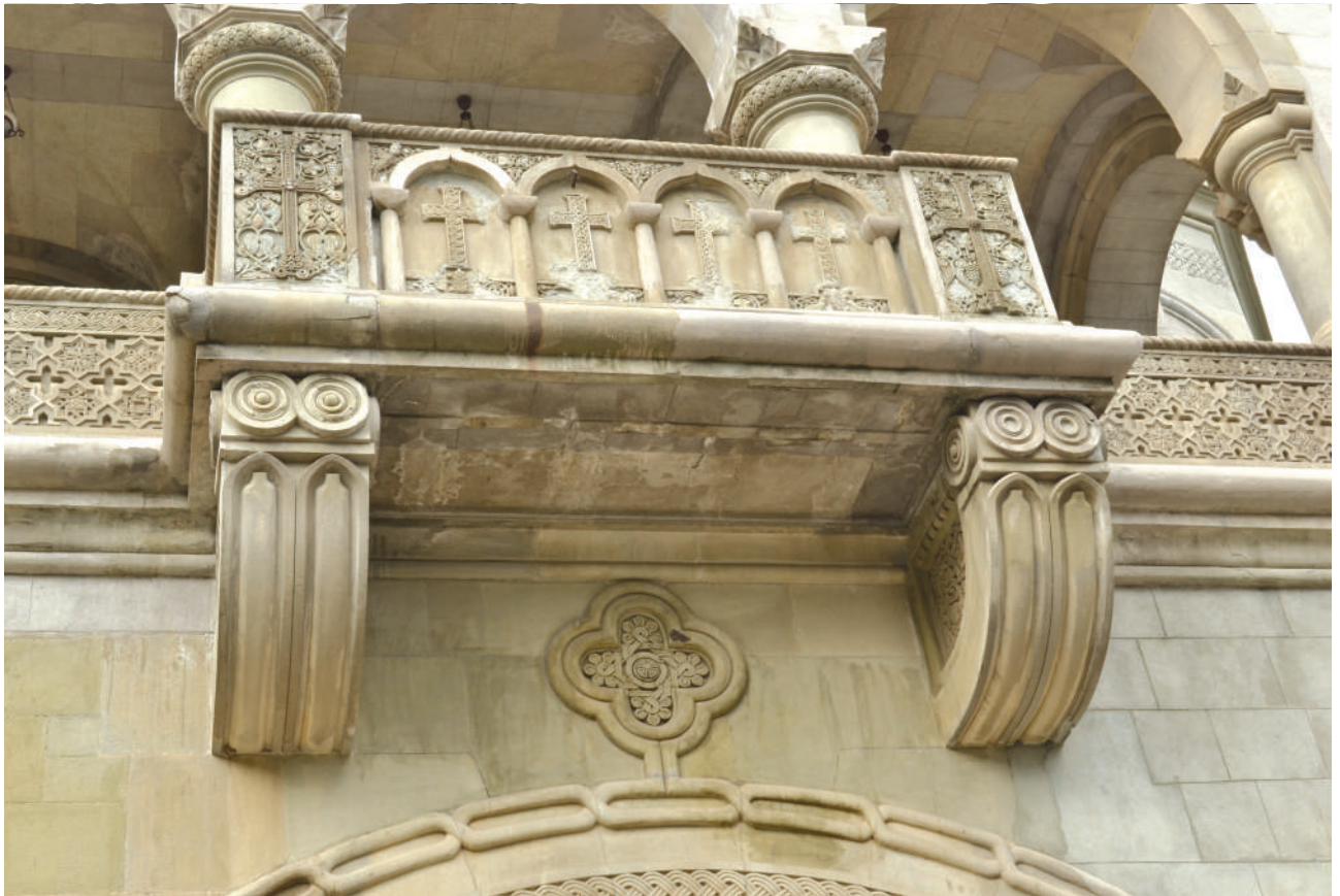
Илл. 114. Балкон арочной лоджии
