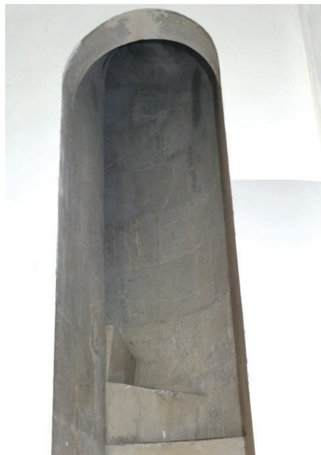
Илл. 96. Лестница, ведущая в отсек звона
