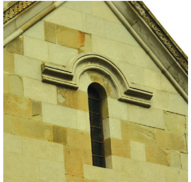
Илл. 104. Окно на колокольне
