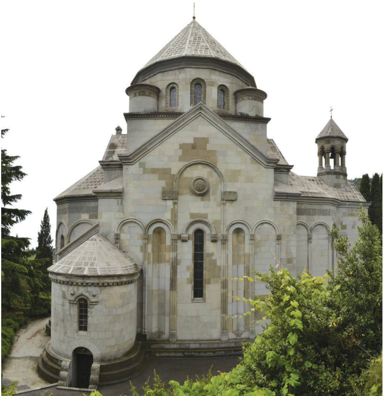
Илл. 11. Северный фасад
