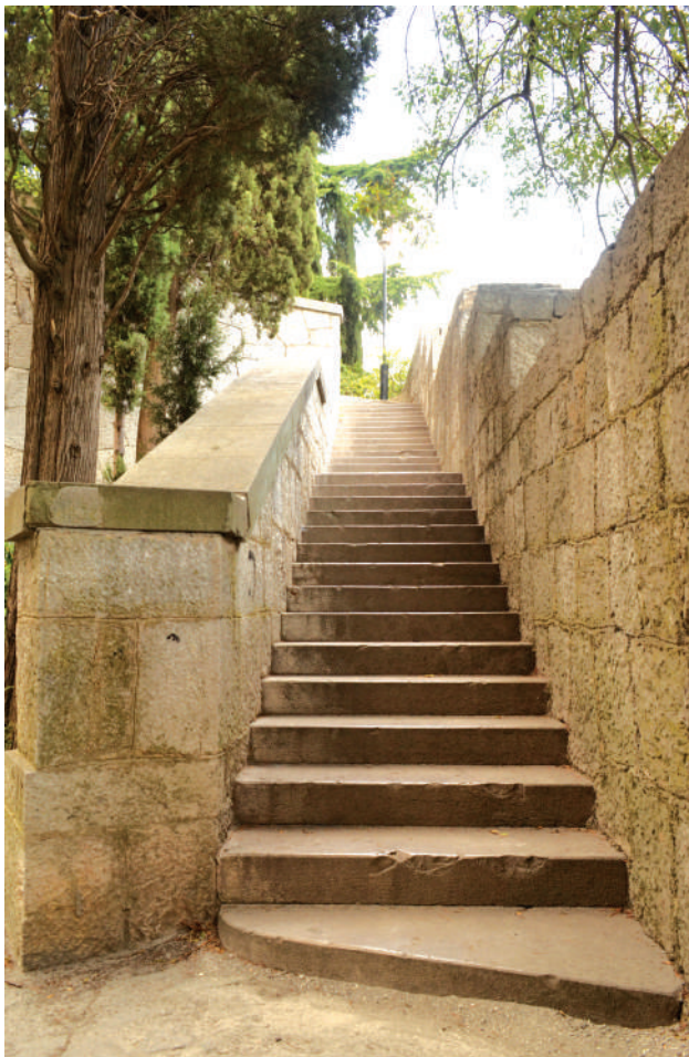
Илл. 163. Восточная лестница, ведущая на верхнюю площадку
