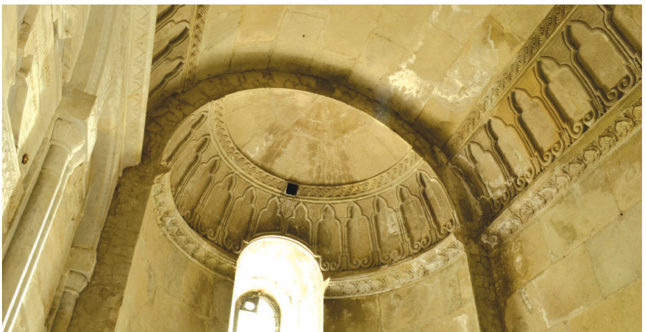
Илл. 60. Фрагмент свода траурного зала
