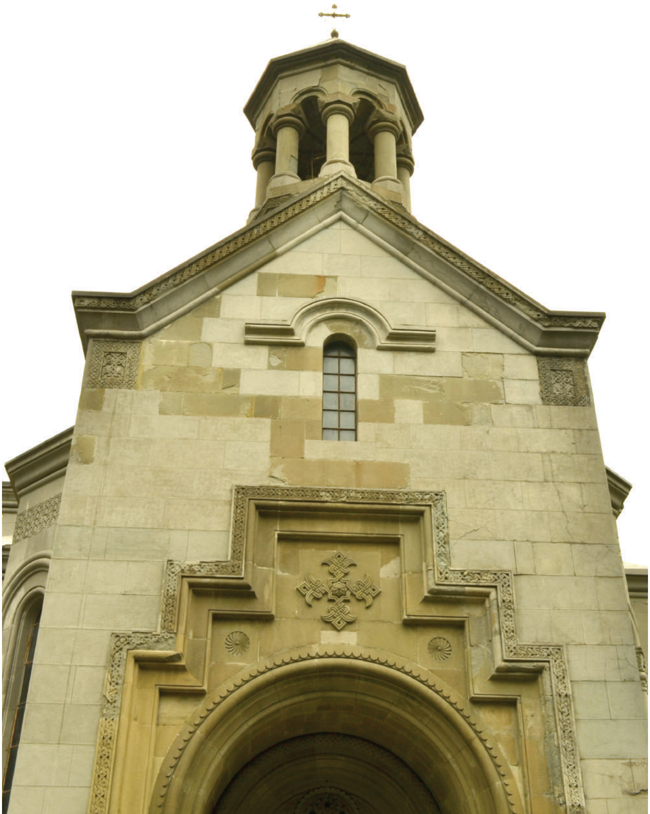
Илл. 98. Колокольня. Отсек звона снаружи
