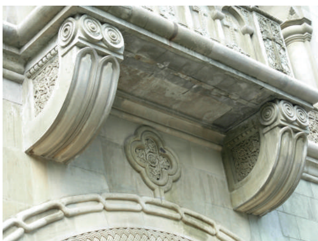
Илл. 115. Консоли, поддерживающие балкон
