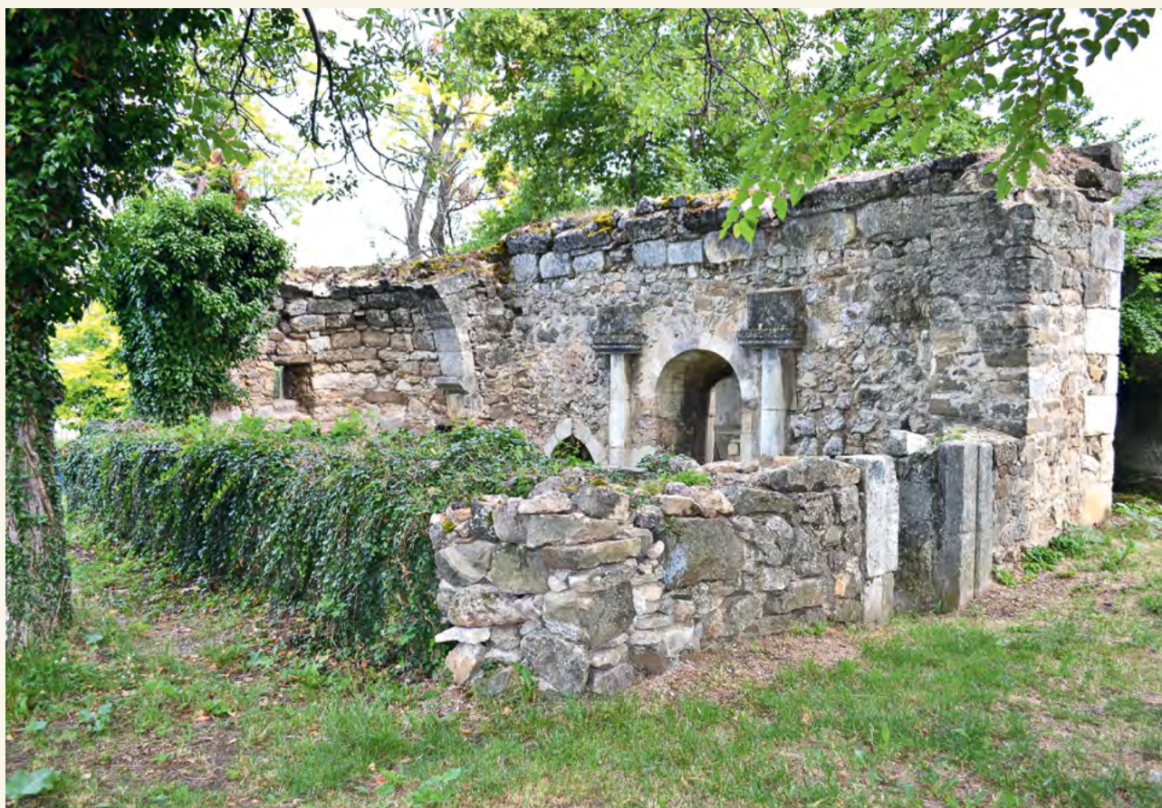
Разрушенная церковь в Старом Крыму. Вид с северо-запада.
