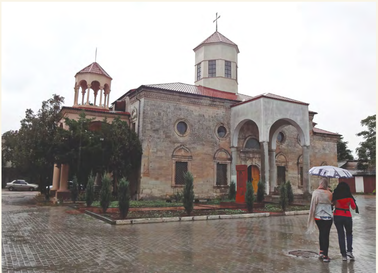
Церковь Святого Никогайоса в Евпатории. Вид с юга.
