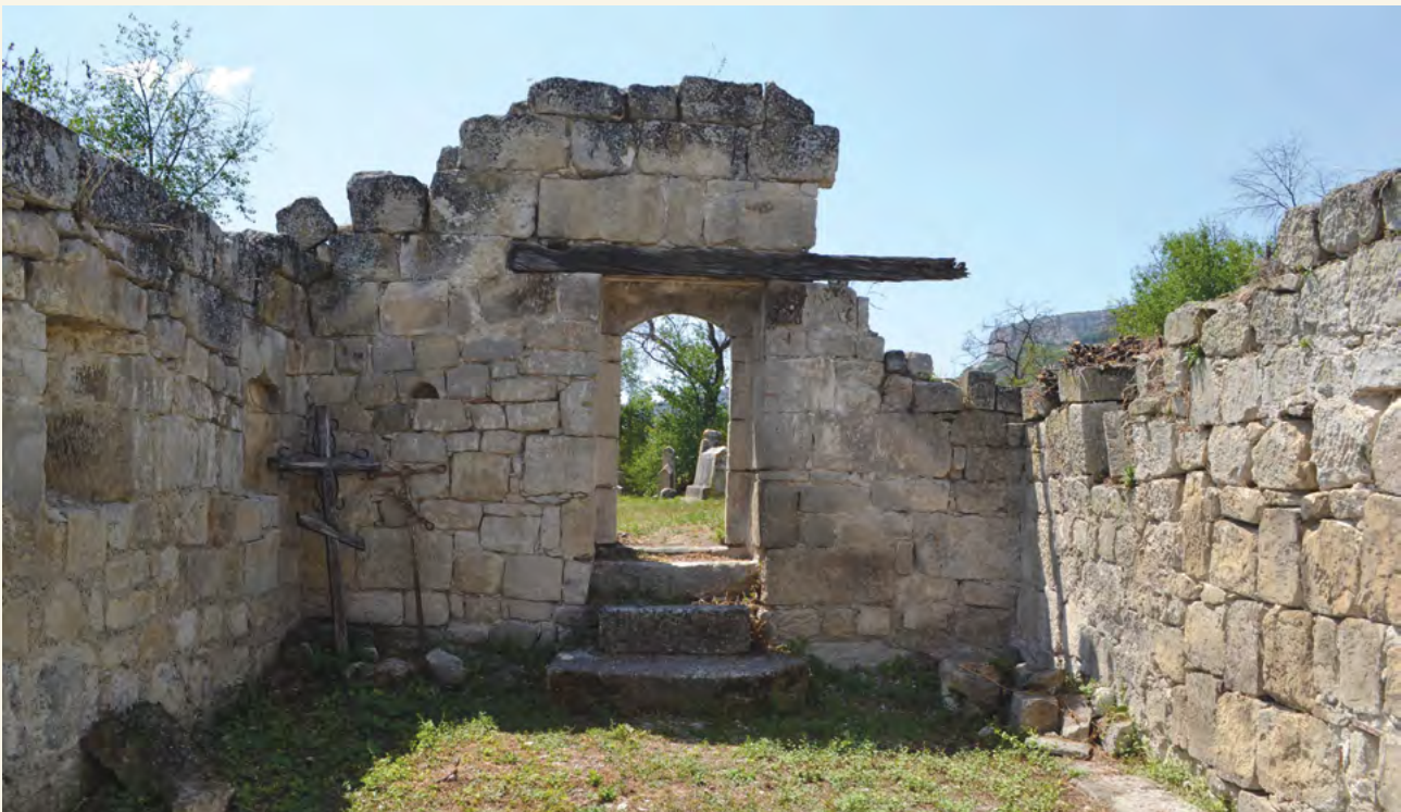
Интерьер разрушенной церкви в Кудрино. Вид на запад.
