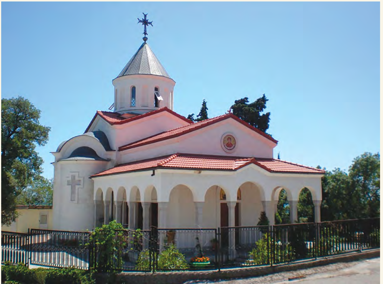
Церковь Покрова в Нижней Ореанде. Вид с северо-запада.
