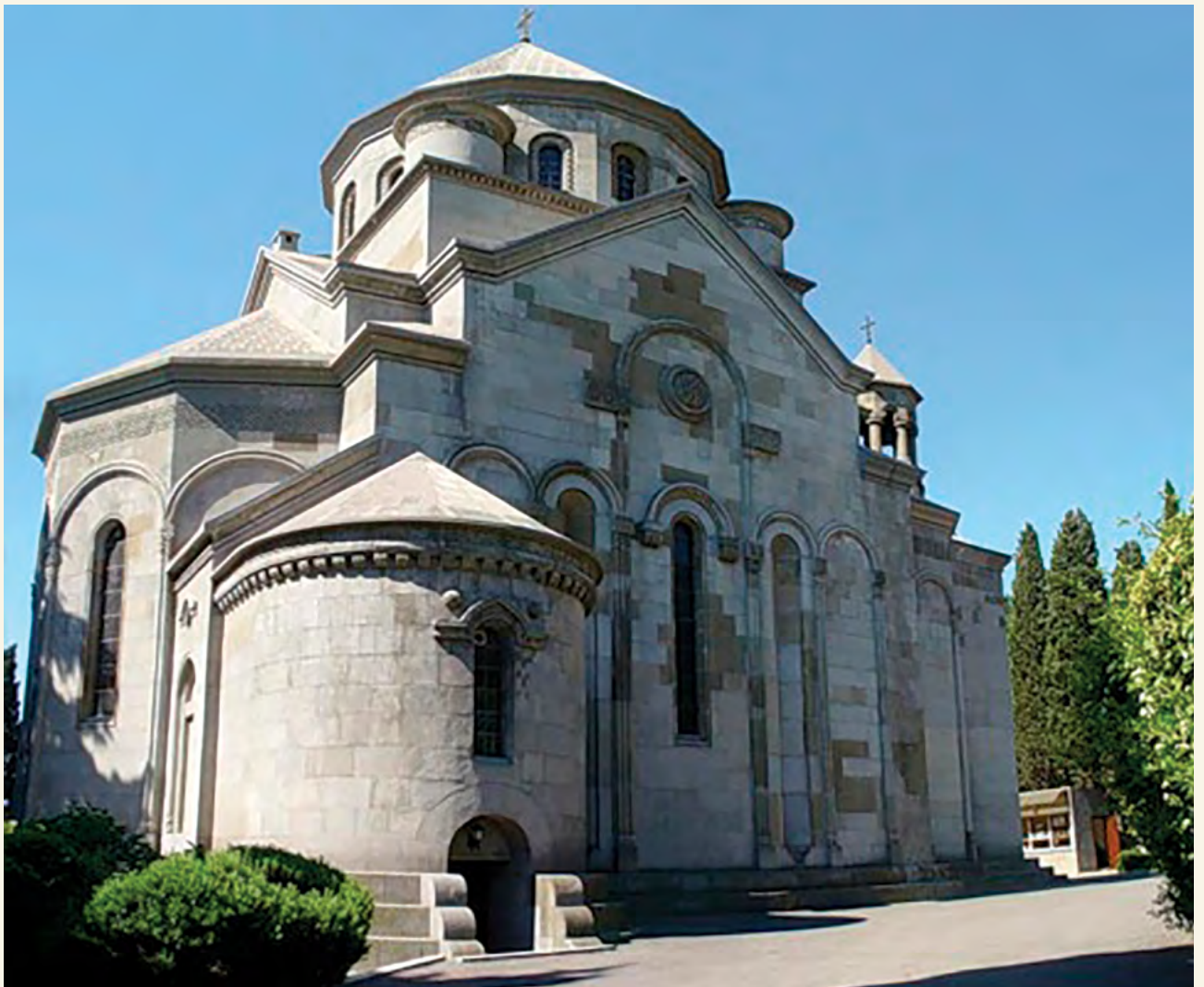
Церковь Святой Рипсиме. Вид с северо-востока.
