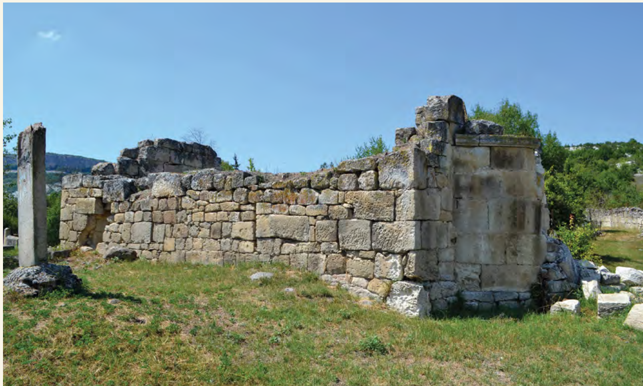
Село Кудрино. Вид разрушенной церкви с юго-востока.
