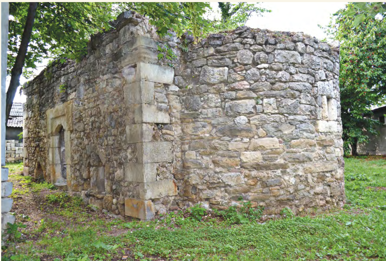
Разрушенная церковь в Старом Крыму. Вид с юго-востока.
