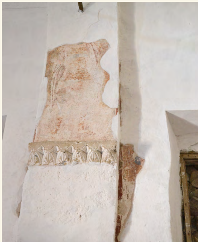
Церковь Святого Степаноса в Феодосии. Основание подпружной арки.
