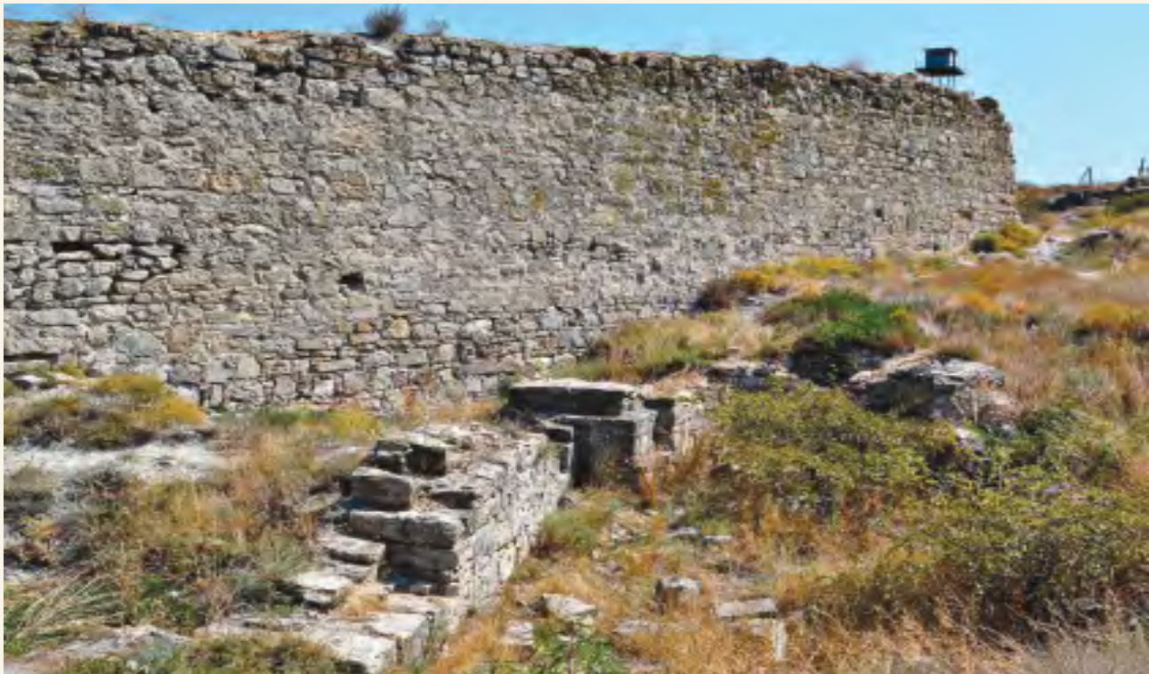
Руины армянской церкви, выявленной в 1982 году. Современное состояние.
