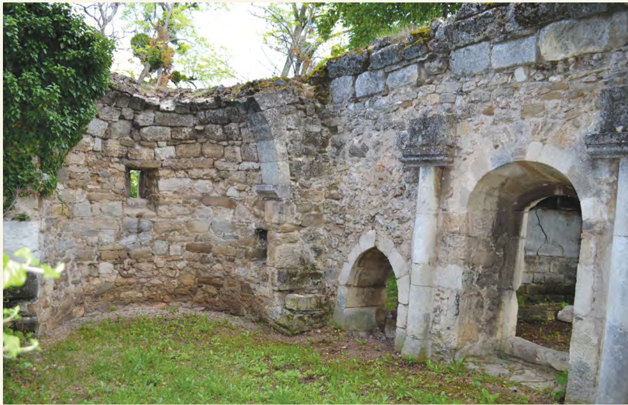
Разрушенная церковь в Старом Крыму. Вид на алтарную апсиду.
