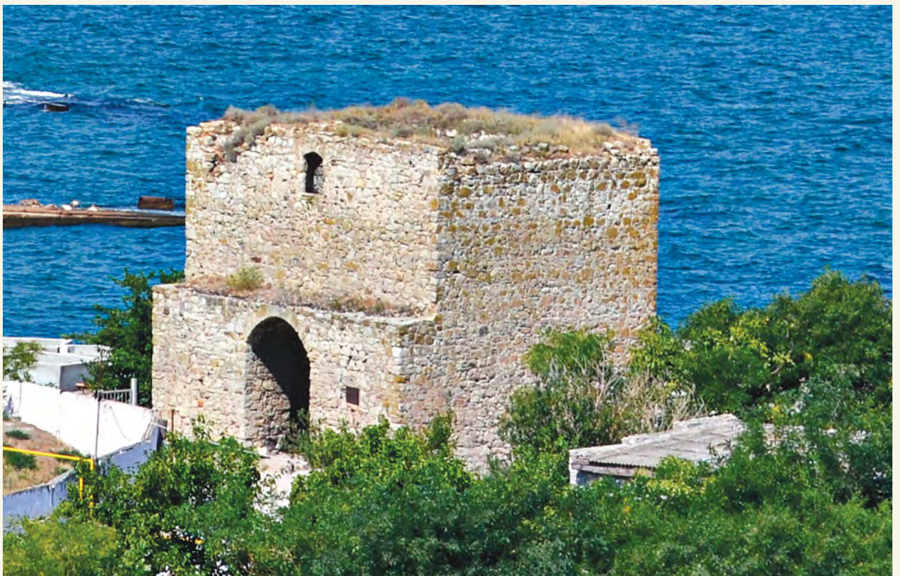
Современный вид доковой башни.
