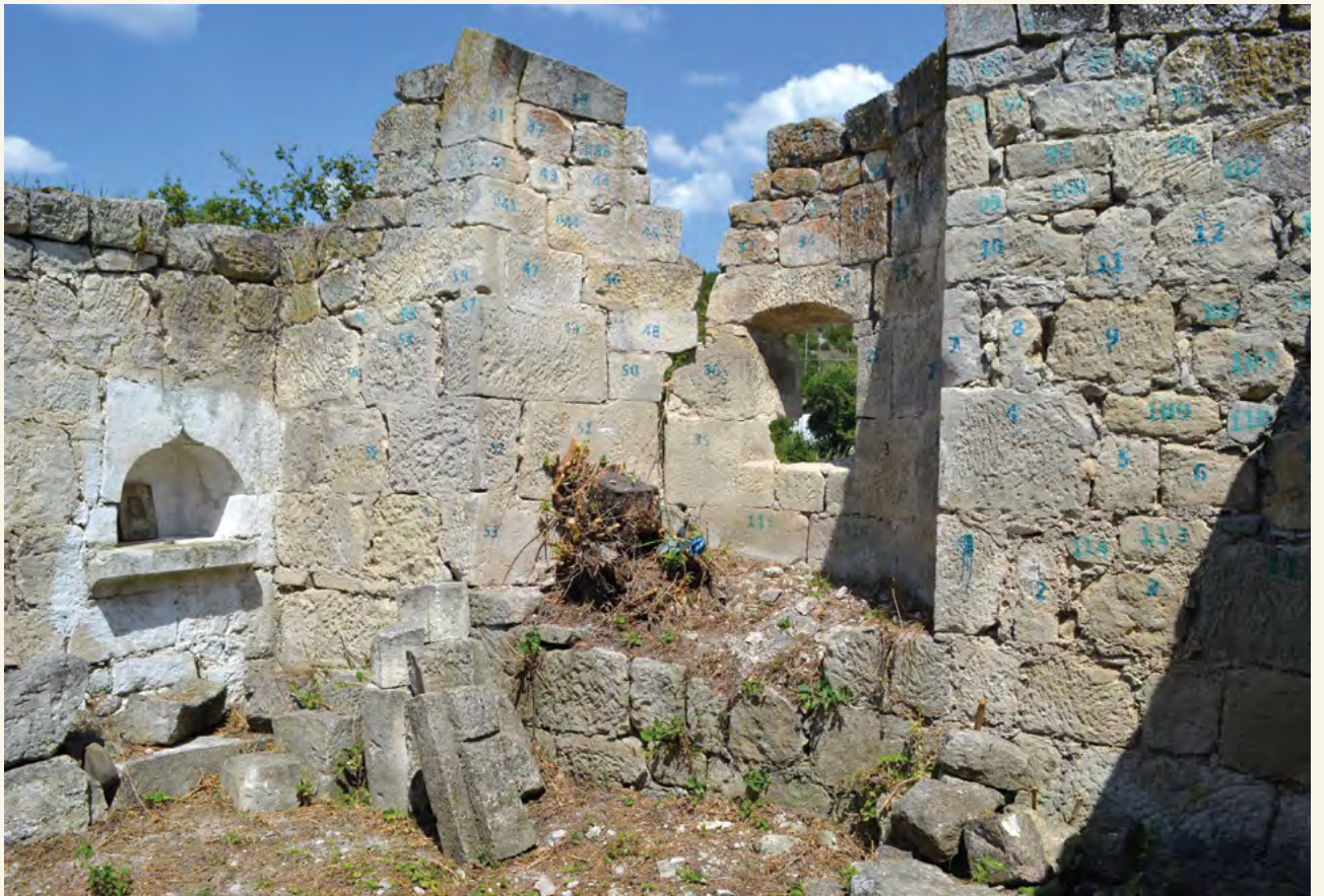
Село Кудрино. Разрушенная церковь. Алтарная апсида и крестильная купель.
