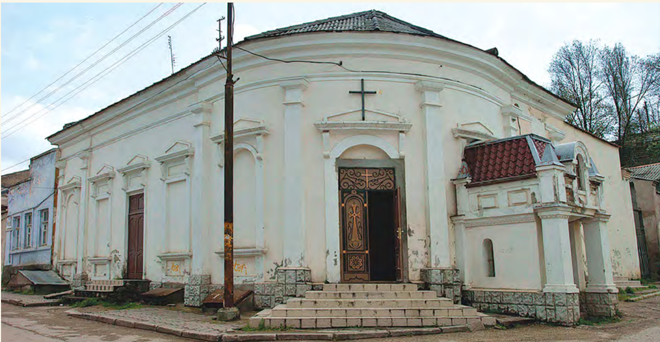
Армянская церковь Святых Архангелов в Керчи. Центральный фасад.
