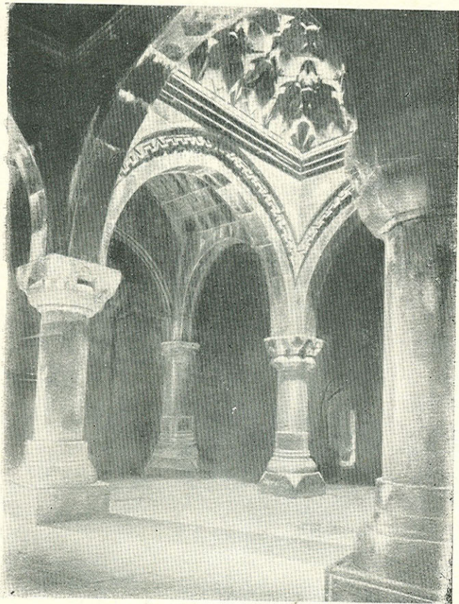
13. Внутренний вид притвора главной церкви
