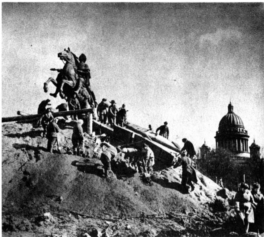
Освобождение памятника Петру I в Ленинграде от защитных устройств.
