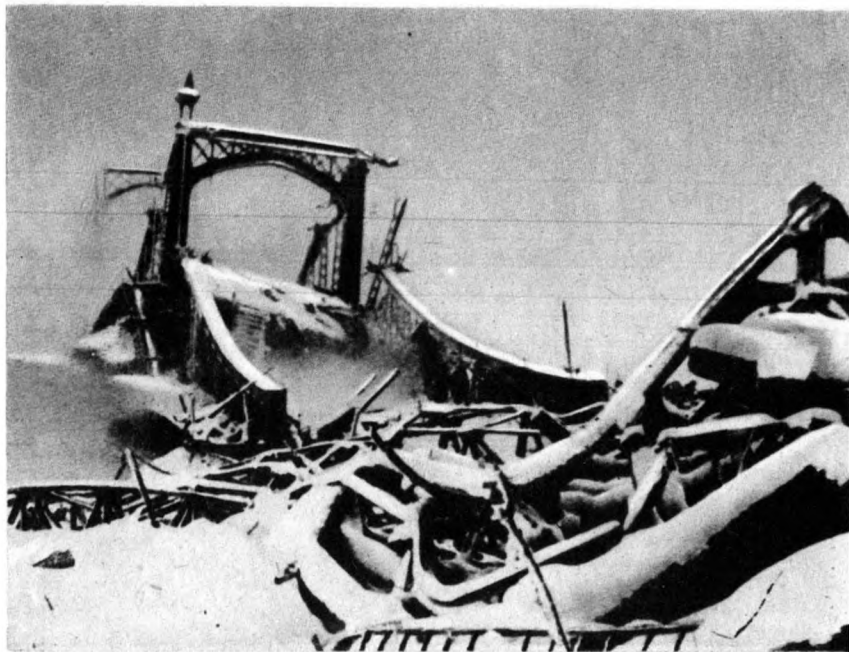
Новгород. Взорванный фашистами мост через Волхов.
